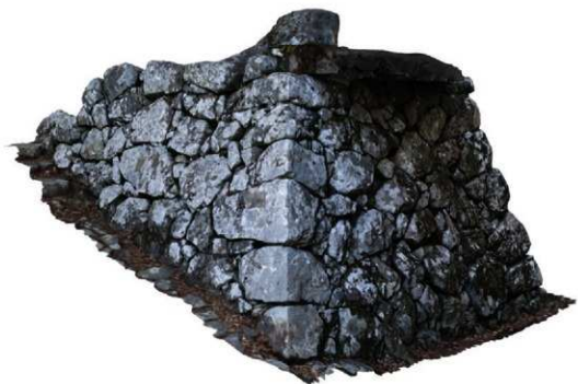
石垣No.301・302隅角部
