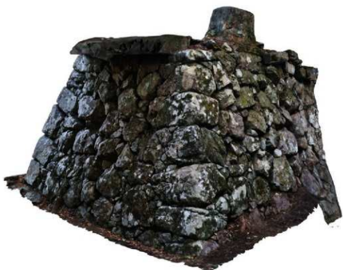
石垣No.302・303隅角部
