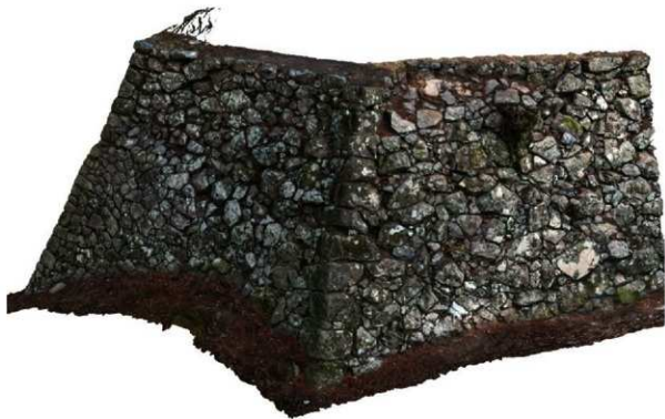
石垣No.324・325隅角部
