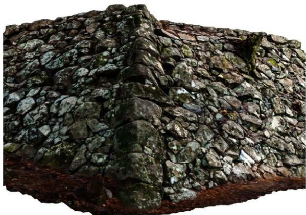
石垣No.324・325隅角部下部
