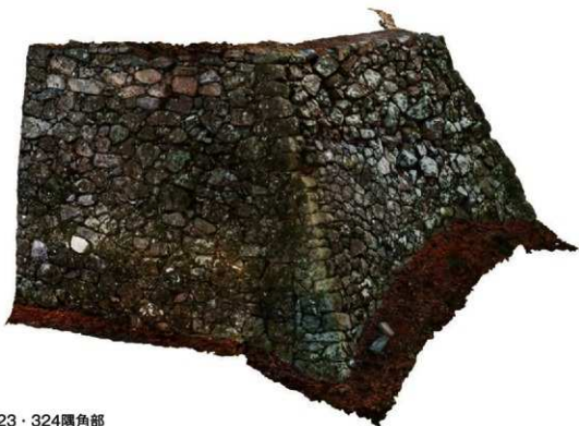
石垣No.323・324隅角部
