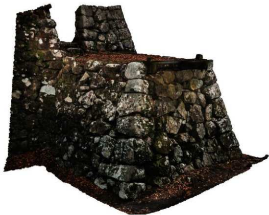
石垣No.109・110隅角部
