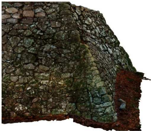
石垣No.323・324ハバキ石垣
