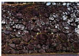
図164 三の丸東面 慶長期石垣 (黄色破線内)
