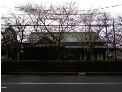
住吉御殿現況 北から
