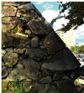
図168 小倉城天守台南西隅石垣
