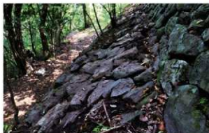
図176 籬壇状石垣 1段目天端の「小端立て」と傾斜の様子
