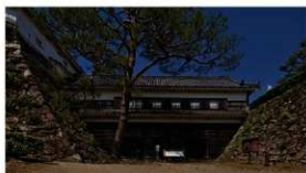
図166 高知城詰門 (下階が堀切を塞ぐ門口。上層の渡櫓を経由して右の二ノ丸から左の本丸へ入る構造)
