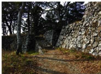
廊下橋付近 北東から
