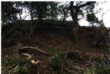
西出丸西側石垣 西南から
