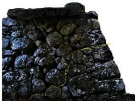
図167 廊下橋下（二の丸東端）石垣 No.302
