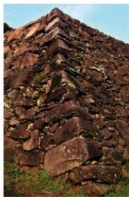
図172 肥前名護屋城 山里口石垣
