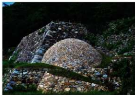
図179 鳥取城天球丸「巻石垣」(復元)
