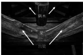
図111 梁に差し込まれた出梁・隅木
