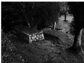
図135 櫓門跡現況 東南から
