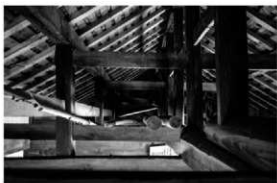
図110 櫓門内部（天井部分）
