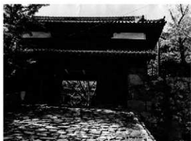
図109 修理前の櫓門(昭和30年頃)
