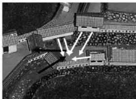
図137 冠木門・廊下橋相関 (佐伯市歴史資料館所蔵模型より) 黒線は導線、白線は射線の方向)
