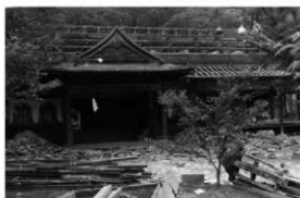
図117 三の丸御殿解体風景(昭和45年)
