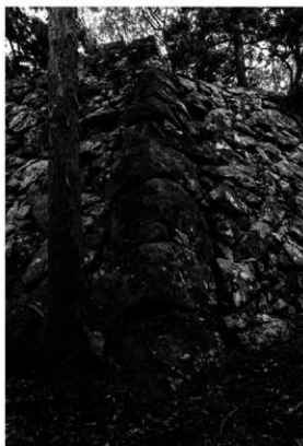
図62 No.323・324の隅角部
