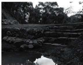
図85 復旧後の雌池石垣 (No.713・714)
