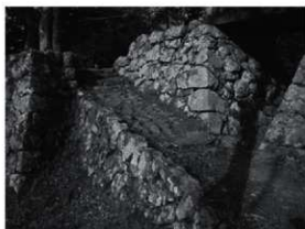
図58 廊下橋下の石垣 (No.301・302)
