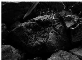
図50 表面に多数の小穴がある築石
