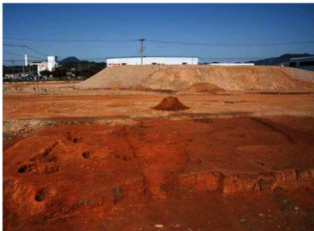
SC9 [左], SC10 [右] 完掘状況 (南から)
