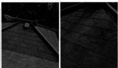
劣化の様子（塗装が剥がれ露出した下地の錆）
