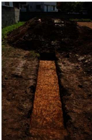
トレンチ3 横出状況(北から)
