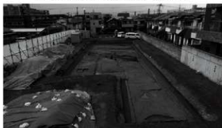
HJ 第737次調査 発掘区全景（東から）
