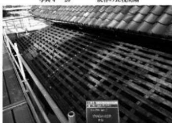
写真 4-21 野地板撤去前状況
