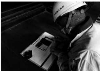
写真 4-7 大工による野帳作図
