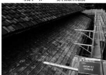
写真 4-18 瓦取外し完了状況
