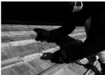
写真 4-87 瓦固定用鋼線施工状況
