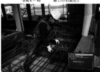
写真4-46 基礎鉄筋配筋状況
