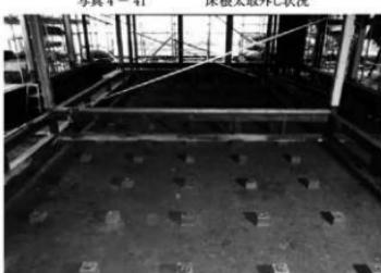
写真 4-42 床束取外し状況
