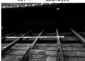
写真 2-8 既設野垂木腐食状況
