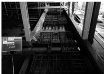
写真4-47 基礎配筋完了
