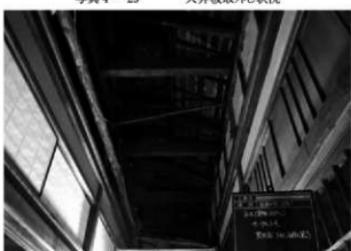
写真 4-30 天井板・下地取外し状況
