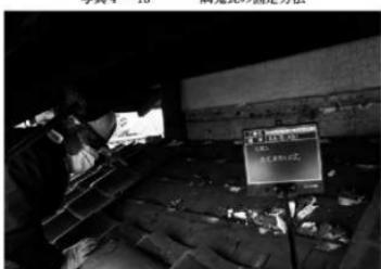
写真 4-14 棟瓦取外し状況
