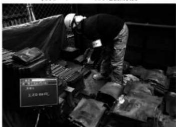
写真 2-2 打音による瓦選別状況
