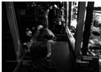
写真4-48 基礎コンクリート打設状況
