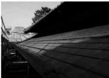
写真 4-24 野垂木・母屋取外し状況
