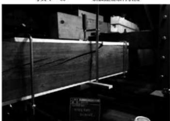
写真 4－61 既存陸梁のワレと補強開始状況
