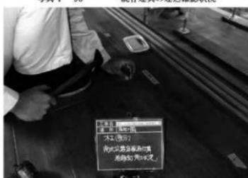
写真 4-97 床縁床板張仕舞 卷頭釘施工状況
