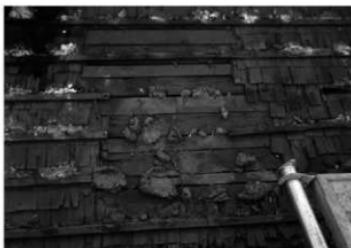
写真 2-5 北面野地板 既往の改修の痕跡
