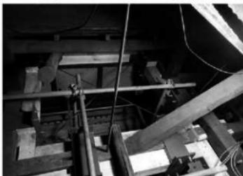
写真4-56 V3プレース設置状況
