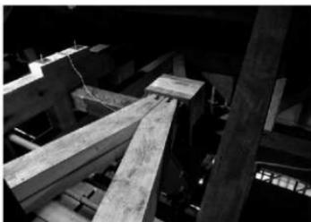
写真4-55 V4プレース設置状況
