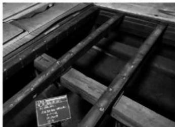
写真2-33 内部根太の釘穴調査
