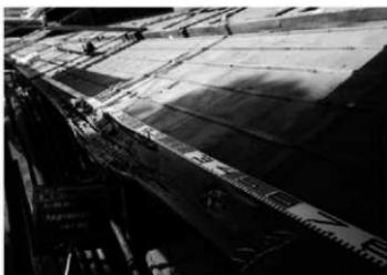
写真 4-23 南面裏甲腐朽確認状況
