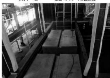
写真4-49 基礎コンクリート打設完了
