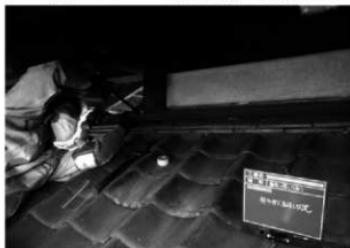
写真 4-16 瓦斗押え取外し状況
