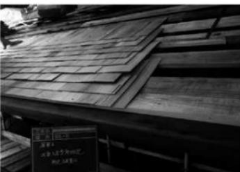
写真 4-79 土居葺き施工状況
