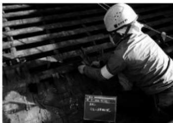
写真 4-19 土居葺き撤去状況
