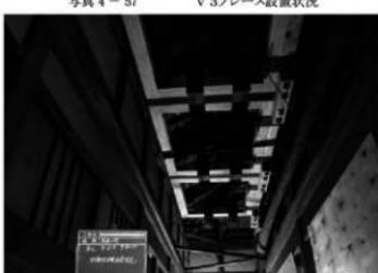
写真4-58 天井裏プレース配設状況
