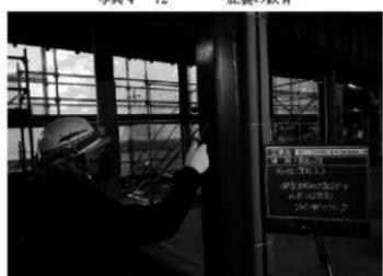
写真4-73 鉄骨上塗り状況
