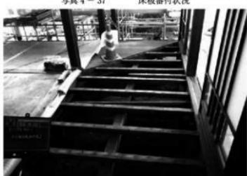
写真 4-38 床板取外し状況
