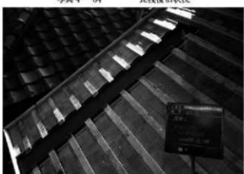
写真 4-85 備下の捨板施工状況
