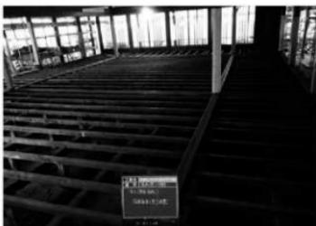
写真 4-39 床板取外し完了
