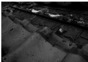
写真 4-15 鋼線による棟瓦の固定状況
