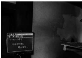
写真 4-107 本漆喰下塗り施工状況
