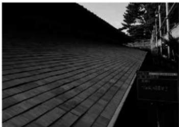
写真 4-83 北面土居葺き完了状況
