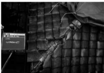
写真 4-11 北西庇隔棟瓦取外し状況
