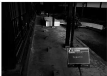
写真 4-35 縁床組取外し状況
