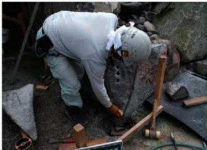
接合相手にも穿孔し、ダボピンと樹脂で接合
