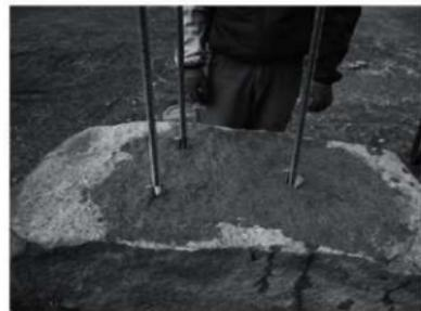
削孔して全ネジボルトを定着（余分は切断）
