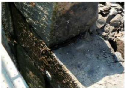
東半石垣 6段目解体時 鉄製アンカ一検出（北から）
