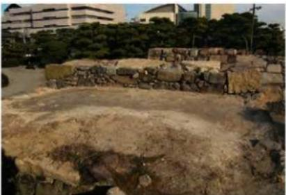
西半石垣石積み後盛土施工完了状況（西から）
