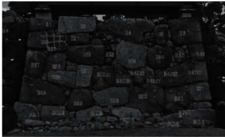
図6-31 西側石垣定点観測箇所図
