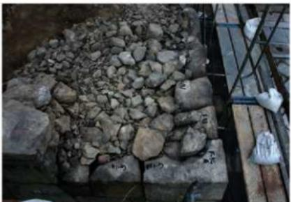
東半石垣 4段目解体時 隅角部の介石設置状況（北から）
