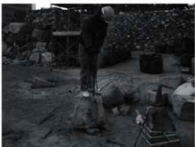
接着養生後に削孔(径30mm 2か所)
