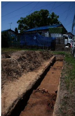
掘削関連遺構全景(南か5)
