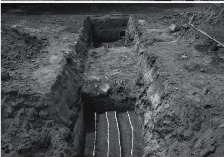
3. 南トレンチ 第3層上面 (北から)
