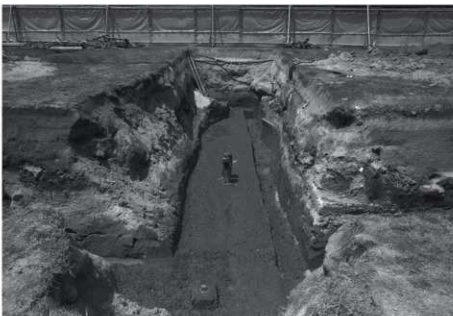
1. 北トレンチ 第3層下面 (南から)
