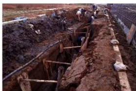
第2トレンチ作業風景（南から）
