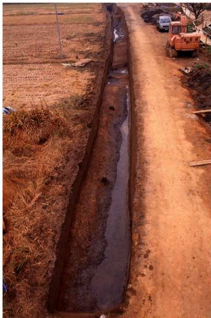
SD-102E 完掘状況 (南から)
