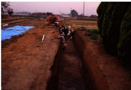
第1トレンチ表土掘削
