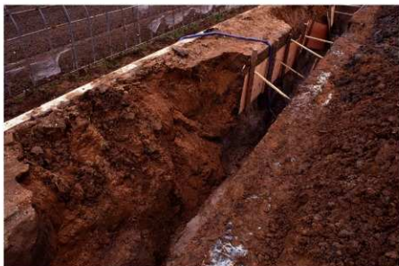
SR-102F 完掘状況 (北西から)
