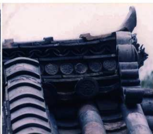
向拝部の道具瓦使用状況(西から)
