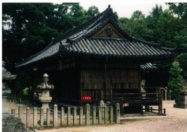
旧拝殿（西から）
