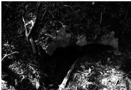
34 H 3号墳 石室 開口部天井石露出状況
