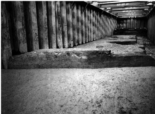
11tr. 中央トレンチ断面（南西から）
