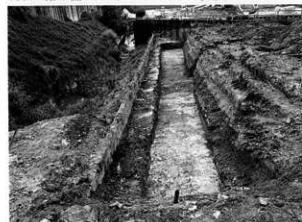
5tr. 完掘状況 (北東から)
