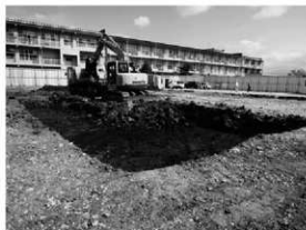
重機表土除去
