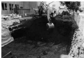
重機表土除去
