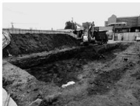
重機表土除去
