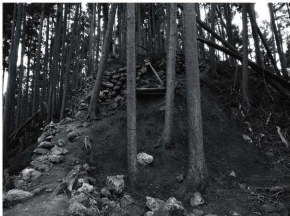
2 郭5西面石垣・郭6石塁（西から）
