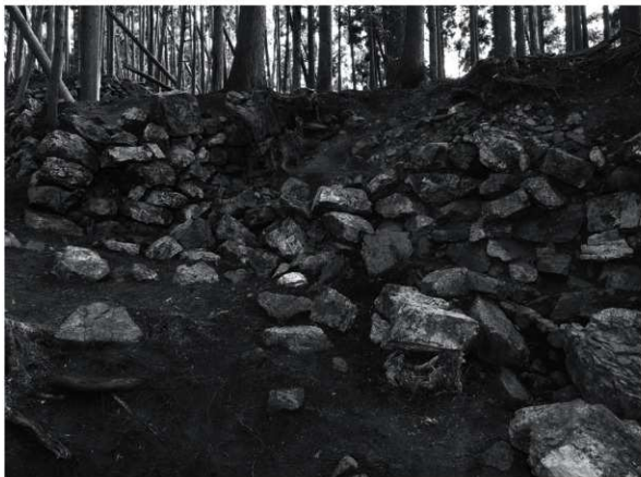
2 郭6北面石垣折れ部分（北西から）
