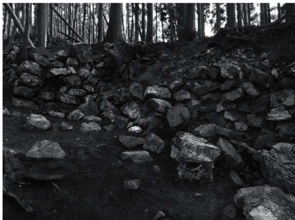
2 郭6北面石垣折れ部分（北西から）
