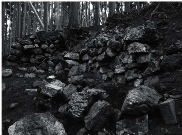
1 郭6北側石塁西面と北面石垣（西から）
