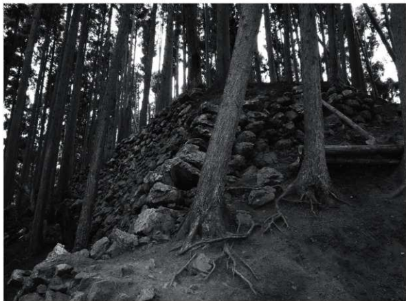
1 郭5北面・西面石垣（北西から）
