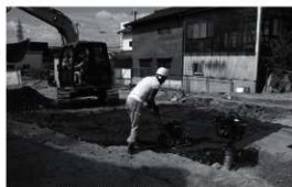
図8 埋戻し風景 (北東から)
