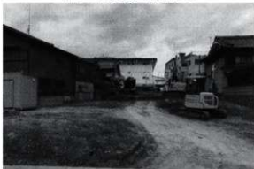
図6 調査前風景 (南から)
