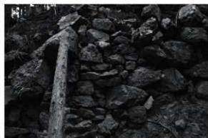
図26 補修箇所2（補修後）（西から）
