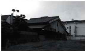
図5 隣地建物 (南東から)
