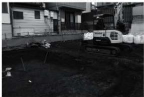
図5 1区埋戻し及び2区重機掘削（南東から）
