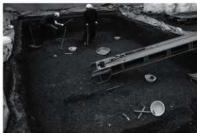
図4 作業風景（東から）
