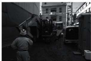
図2 重機搬入状況（北から）
