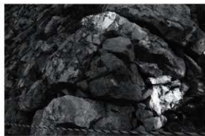
図24 補修箇所1（補修後）（西から）
