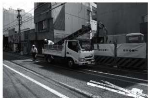
図4 器材搬出状況（南西から）
