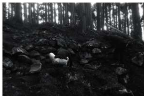
図5 石垣清掃作業風景（北から）
