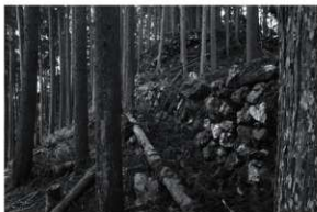
図3 調査前全景（北西から）
