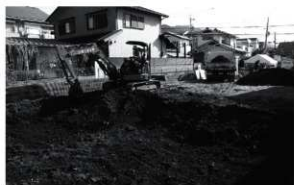
図3 機械掘削状況（第9次）（北西から）
