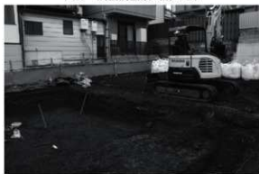
図5 1区埋戻し及び2区重機掘削（南東から）
