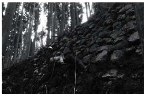
図4 石垣清掃作業風景（北西から）
