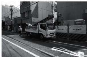
図4 器材搬出状況（南西から）
