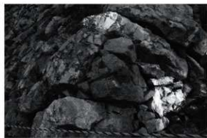
図24 補修箇所1（補修後）（西から）
