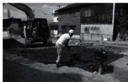
図8 埋戻し風景 (北東から)
