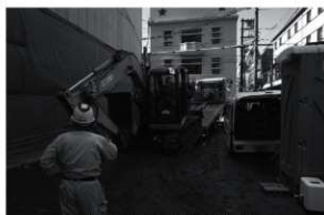
図2 重機搬入状況（北から）
