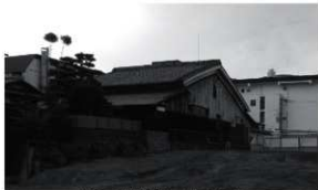
図5 隣地建物(南東から)
