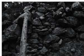
図26 補修箇所2（補修後）（西から）
