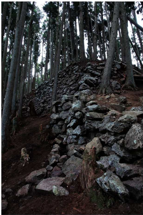
1 郭5北面・西面石垣（北西から）
