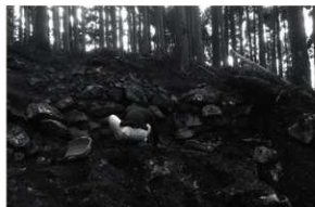
図5 石垣清掃作業風景（北から）
