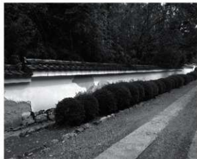
図62 調査前現況(南西から)
