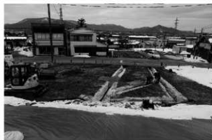
4. 暗渠設置状況（西から）
