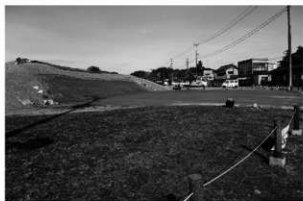
5. 土壘復旧状況（南から）
