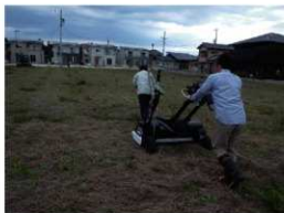
地中レーダー探査の実施状況
