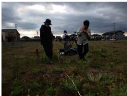
地中レーダー探査の実施状況
