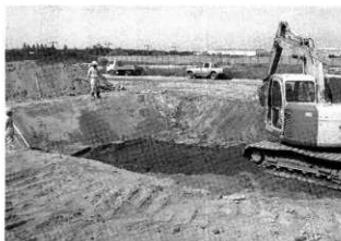
写真19 2T調査状況
