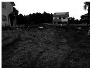
埋め戻し後 (南から)
