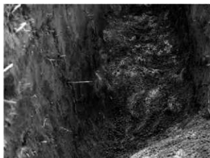
溝の一部掘削 (1)
