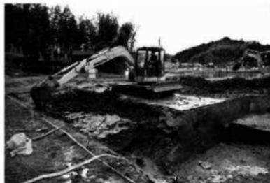
写真1 バックホーによる表土除去
