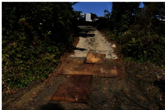
安全敷板使用状況
