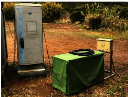
仮設トイレ、ベルトコンベア用発電機、コード、配電盤
