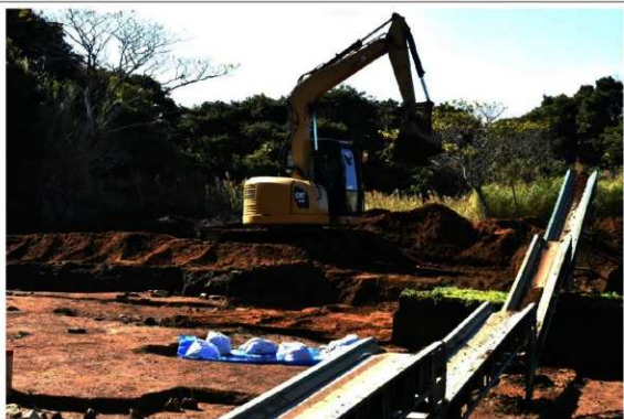
重機排土処理作業
