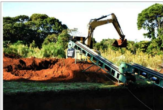
重機排土処理作業
