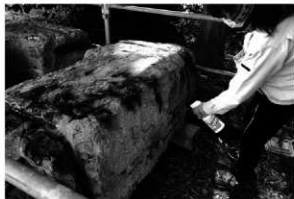
写真3 生物除去剤噴霧作業風景
