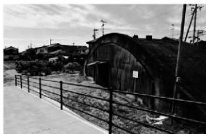
写真1 掩体壕周辺状況①(南東より)
