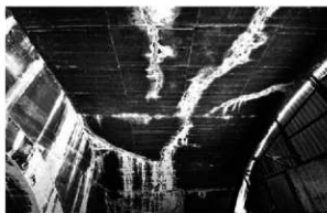
写真6 1区掩体壕内面型枠痕(西より)
