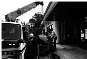
写真8 館内設置作業状況
