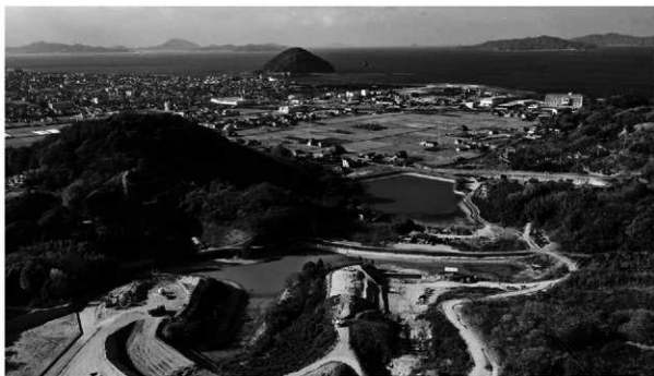
写真 1 調査地全景（東上空より）
