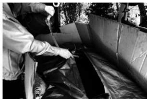
写真6 強化剤含侵作業状況
