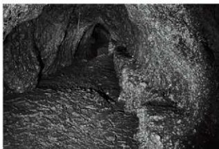
図版 6-3 隧道内状況
