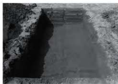
4 T遺構検出状況 (南から)
