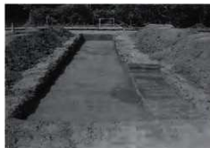
3 T遺構検出状況 (南から)
