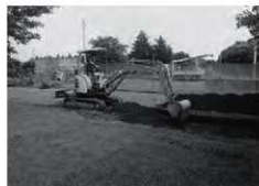
重機稼働状況
