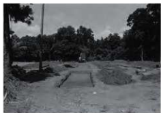
6 T遺構検出状況 (南から)
