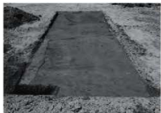
5 T遺構検出状況 (南から)
