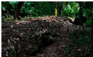
写真 91 土留石積 北東から
