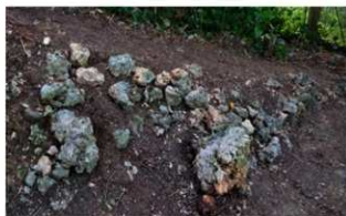
写真 150 石積部分 東から
