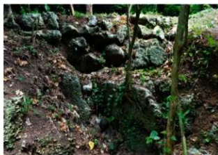
写真 16 下流側から見た埋立部
