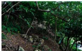
写真127 土留石積 東から
