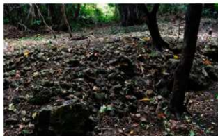
写真 132 同区間の谷側法面 西から
