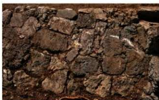
写真 86 石張法面 北から
