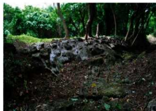
写真 18 上流側から見た埋立部（練石張）
