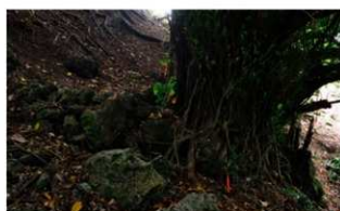
写真 134 石積の状況 北東から
