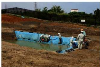
図版 I - 6 トレンチNo.1 排水作業
