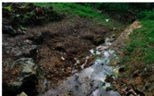
写真72 吸い込み口より下流側の状況
