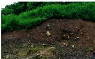
写真 118 湧出口周辺の状況 西から
