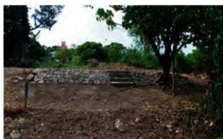
写真 83 石段と石張法面 北から
