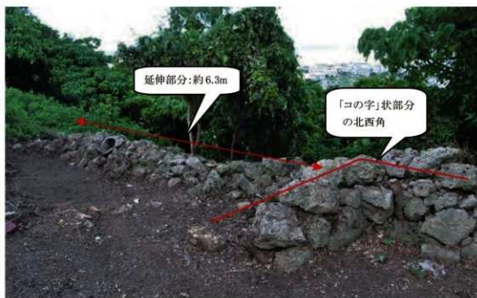
写真145 石積の「北西角」から西へ続く部分 南東から
