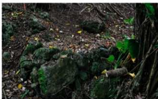
写真 135 石積の状況 北東から
