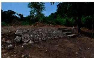
写真 84 石段と石張法面 東から
