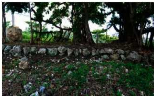
写真 56 同石積 (基礎 7) 北から
