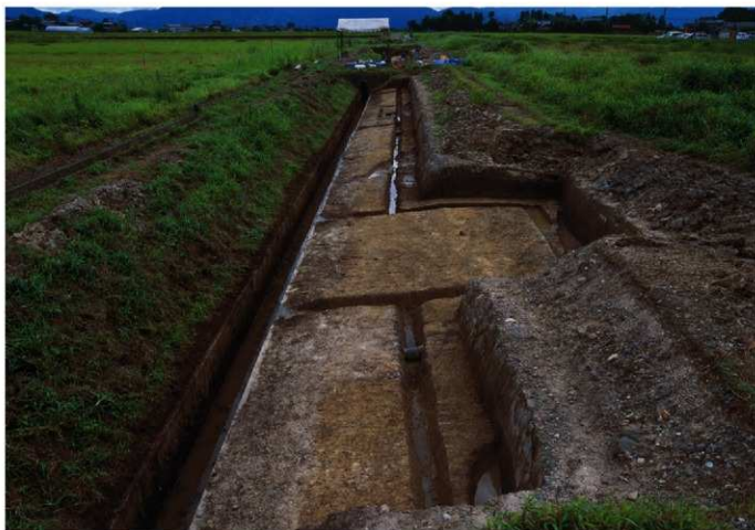
4区 (70-4D・5D・5E・6E 付近) 完掘状況 (北西→南東)
