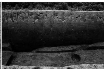
3区 SD89・SE212 土層断面 A (北東→南西)
