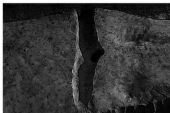
SD78、P121 完掘 北から
