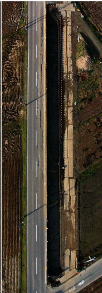
2区全景空中写真
