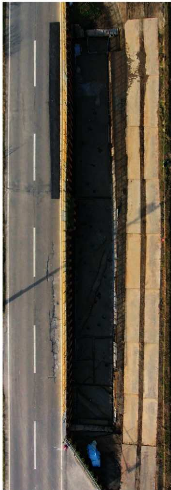
1区全景空中写真
