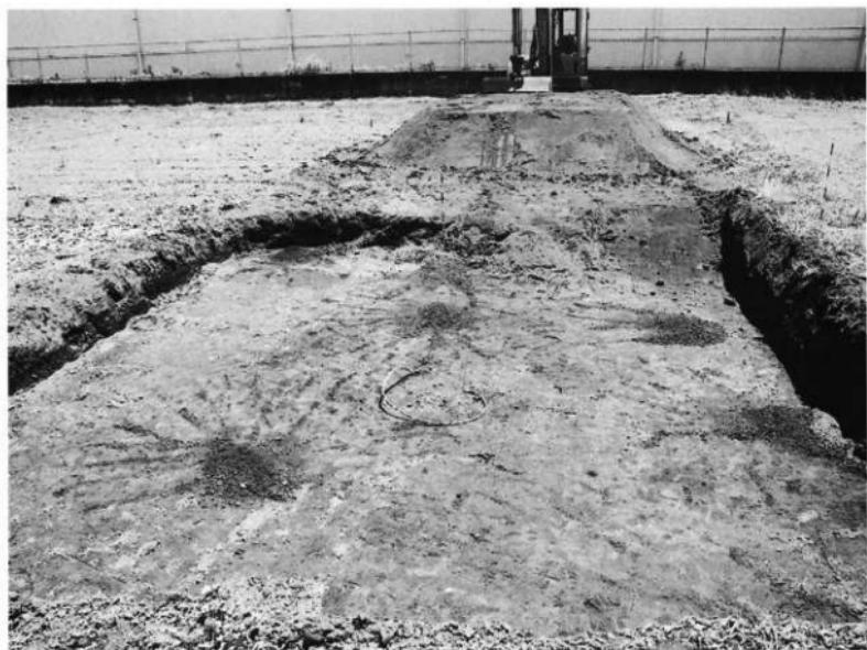
表土掘削状況（西側より、廃土を成形填圧し土砂の流失・飛散を防ぐ）
