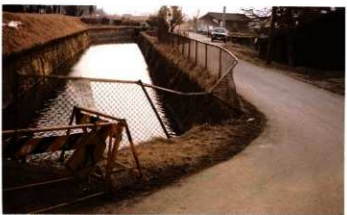
③外側5-3石垣 新フェンス設置前（東より）
