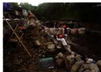
崩壊築石撤去工
