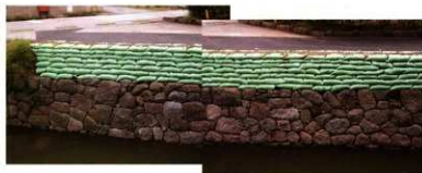
北側竣工（西から）
