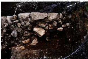
A列石垣と裏込め (東から)
