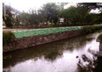
竣工（北西から）
