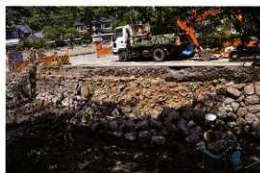
崩壊部裏込め検出（下部に崩壊築石、南西より）
