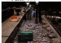
B列裏込め栗石転圧工（北から）
