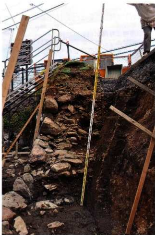
外側1-1-1石垣北端 築城時の築石と裏込
