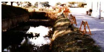
昭和54年度の土壌設置工事前の外側1-1地点土盛
