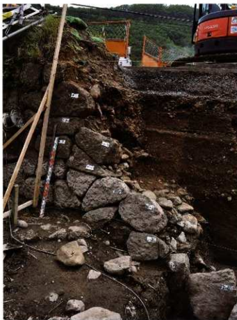
外側1-1-1石垣 今回修理範囲の北端
