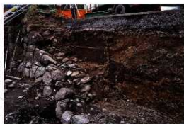
G・H列石垣と裏込 (南西から)
