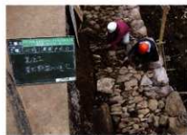
栗石の並べ状況裏込め工
