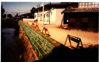
②外側1-1石垣 植生土囊設置後（南より）
