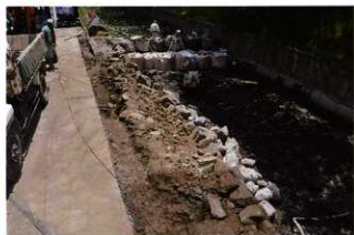
③アスファルト・砕石除去 (北から)
