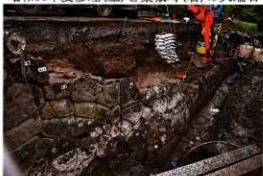
石垣解体作業
