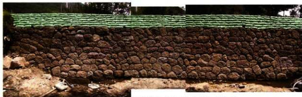
石垣積み完了（合成写真・西から）
