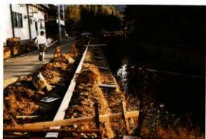
⑤道路縁石コンクリート壁・排水管設置（北より）
