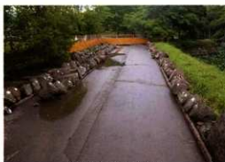
解体築石管理状況
