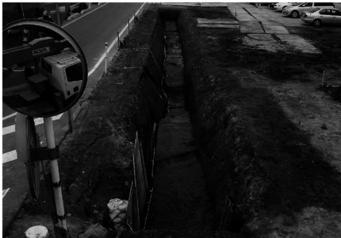
3区完掘状況1（東から）第15次調査地
