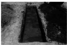
3トレンチ (南から)
