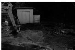
1. 前戸遺跡（第3地点）調査状況
