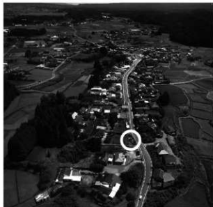
(1) 中浦道路遠景 (西から) (丸が中浦道路)
