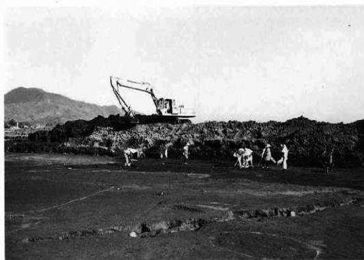
2 重機による表土剥ぎ（A地区、第1次 C-23グリッド付近）
