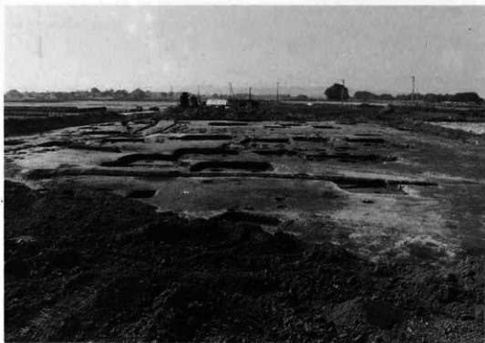
2 前田遺跡（第Ⅲ次調査区）西部付近（東方より）
