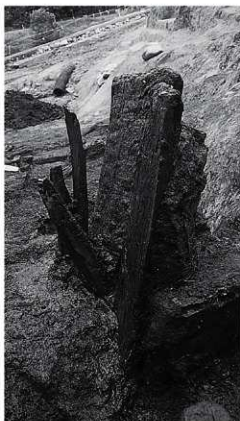
土留部側面 東から
