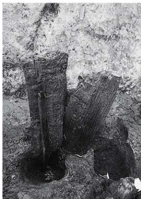
土留部打ち込み状況 南から
