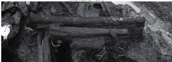
導水路検出状況 西から
