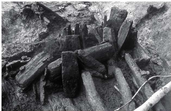
堰部検出状況 東から
