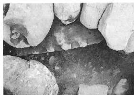
5. 横道と前庭部仕切り石の矢張り
