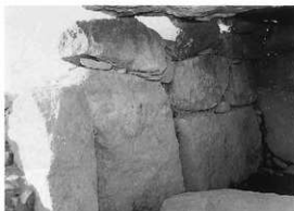
6. 左側壁の石積み
