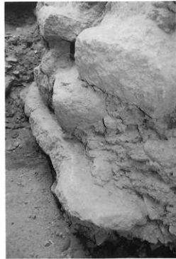
6. 左側壁の崩れ状態
