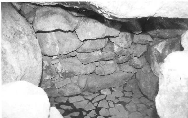
1.右側壁の石積み(持ち送り)
