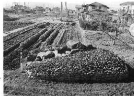
8. 崩落していた天井石を元に戻す (墳裾の石積み、墳丘の礫は復元)
