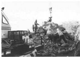
2. 崩落した天井石を元の位置に戻す
