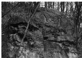
4 臼田町北端離山南西隅山裾の志賀溶結凝灰岩の節理
