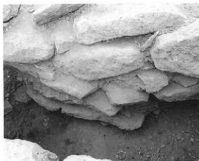
3. 玄室へ崩れかけた左側壁
