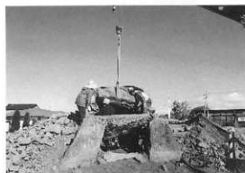
6. クレーンでずり落ちた天井石を戻す
