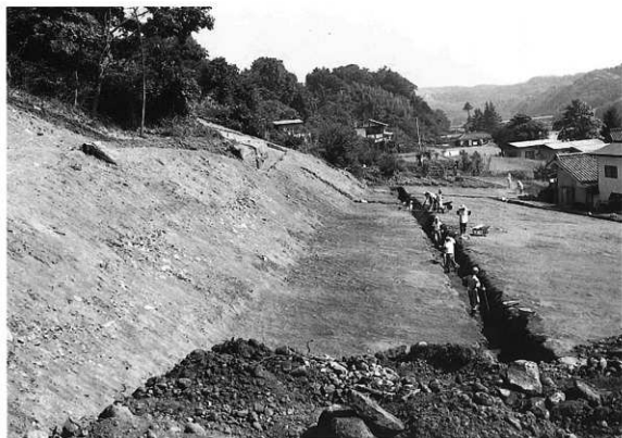
32. トレンチ調査
