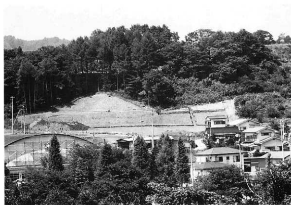
24. 第2次発掘調査地区近景
