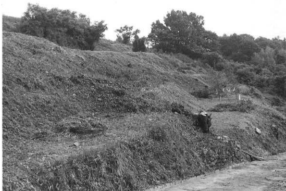
43. 調査地区北部
