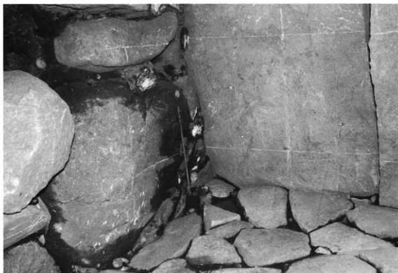
玄室・奥壁の状態
