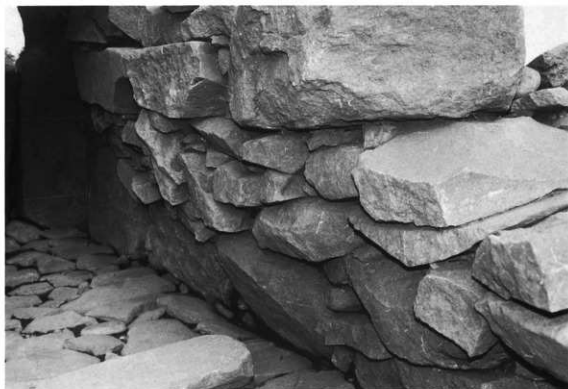
東側圓壁の状態
