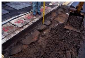
石組水路検出状況（北東から撮影）
