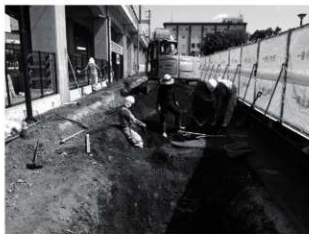
図 5 ①ブロック作業風景 (南から)
