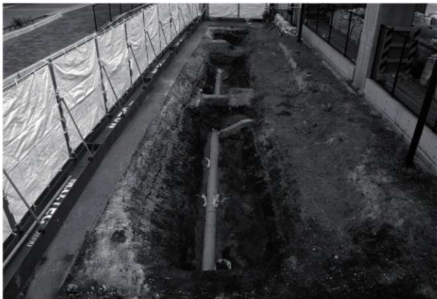
1 ①ブロック南半全景（北から）
