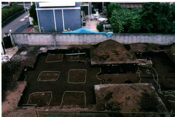
2. 北側妻より3列目から5列目礎石据え方（南から）
